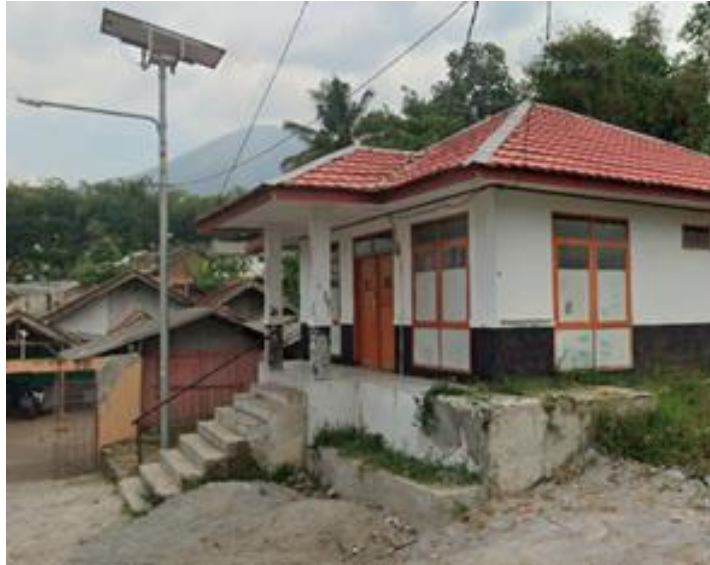
Gambar 2. Kondisi PUSTU Desa Kandangmukti (Dokumentasi, 2024)
